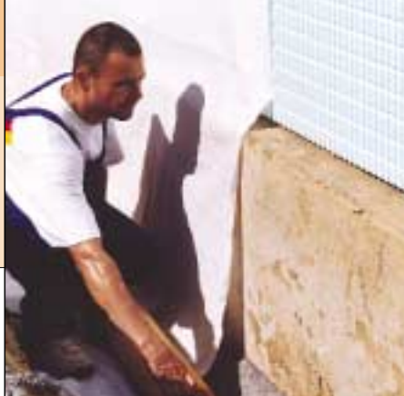
2 Płyty styropianowe z rowkami drenażowymi (fot. Austrotherm)
