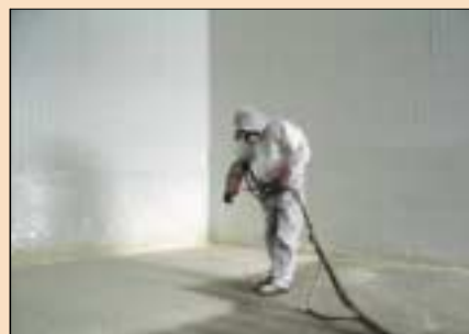
6 Natryskiwanie pianki poliuretanowej (fot. Izolacje Plumers i Wspólnicy)
