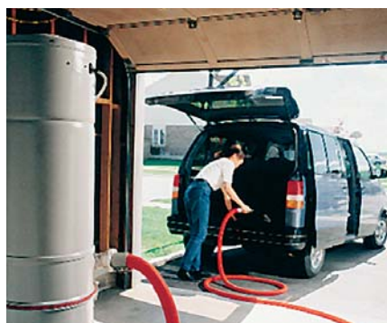
3 Jednostka centralna w garażu to bardzo wygodne rozwiązanie – umożliwia bezpośrednie podłączenie zestawu samochodowego (fot. Smart Arrows) ▲
