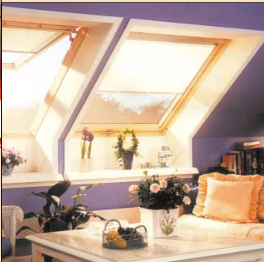
9 Szpaleta to rodzaj kasetonu stanowiącego obramowanie okna (fot. Velux)
