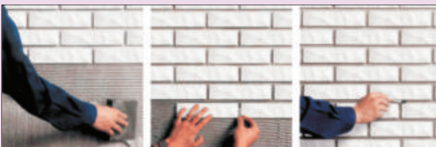
5 Sposób układania płytek silikatowych. Fugę wygładzamy pędzelkiem (fot. Silka)
