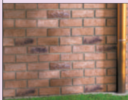
10 Ściana wykończona panelami elewacyjnymi (fot. Vox Industrie)
