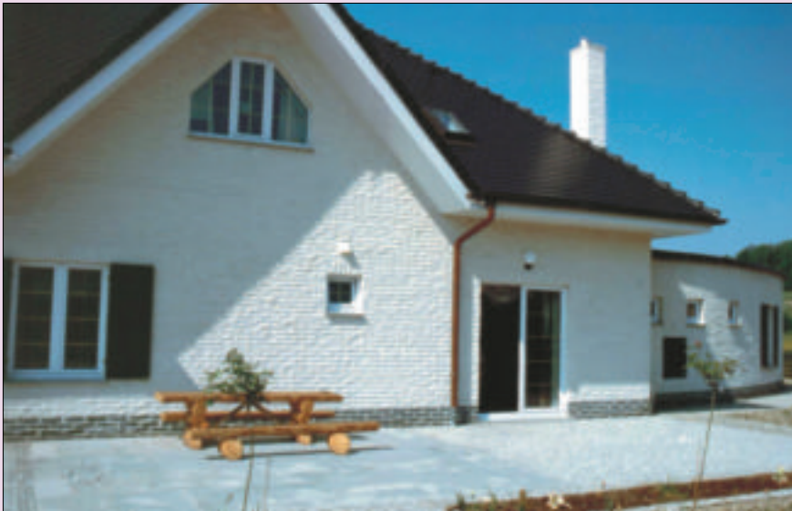
4 Typowa elewacja z płytek silikatowych ma oryginalną fakturę i śnieżnobiały kolor (fot. Silka)
