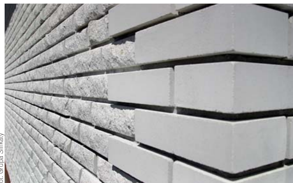
▲ ▲ Ściana trójwarstwowa to dobre i efektywne rozwiązanie. Spoiny w ścianie osłonowej muszą być jednak starannie wypełnione i ukształtowane
