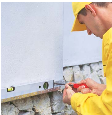
▲ W czasie wykonywania izolacji ścian najważniejsza jest dokładność pracy
