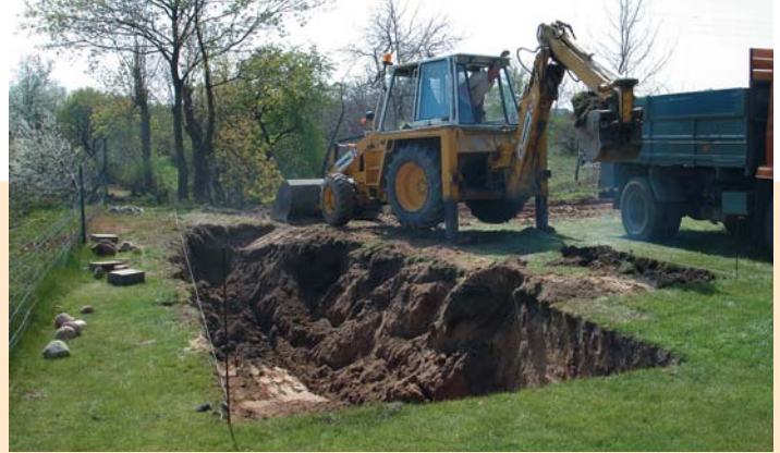
▲ Pierwszy etap budowy to wykonanie wykopu
