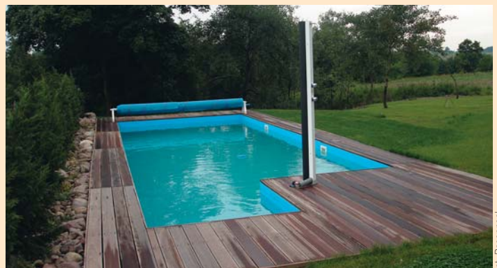
▲ Na końcu wykonuje się obejście basenu, w tym przypadku stanowi je drewno egzotyczne. Po uzdatnieniu i podgrzaniu wody można się kąpać i cieszyć własnym basenem
