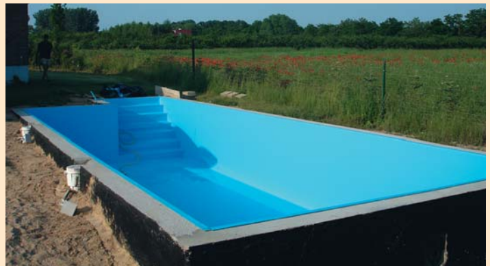
▲ Nieckę należy zaizolować od strony zewnętrznej, docieplić ściany i można zacząć obsypkę basenu
