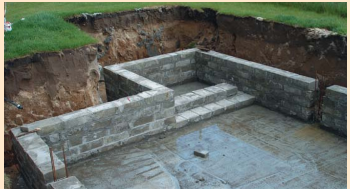
▲ Następnie można zacząć murować nieckę z bloczków, pozostawiając wolne miejsca na słupy zbrojeniowe
