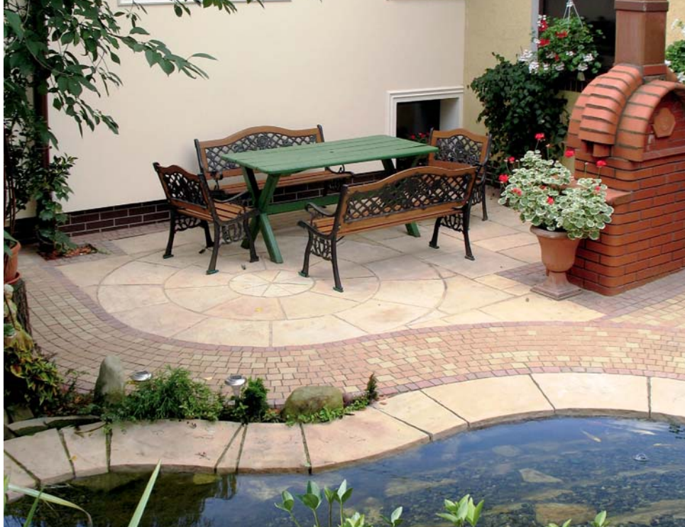
▲ Kostka brukowa produkowana jest w kilku grubościach, w otoczeniu domów jednorodzinnych stosuje się elementy o grubości 4–6 cm
