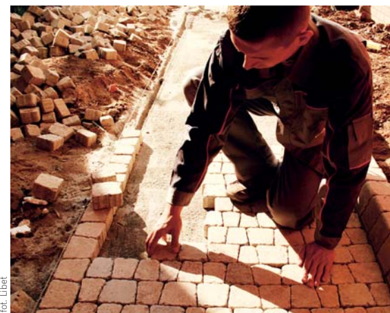
▲ Układanie kostki
