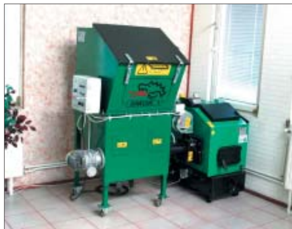
6 Kocioł ze stojącym obok podajnikiem (fot. Moderator)
