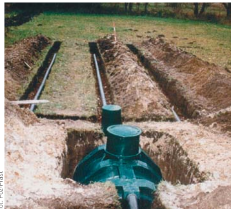
▼ Drenaż rozsączający w gotowym wykopie
