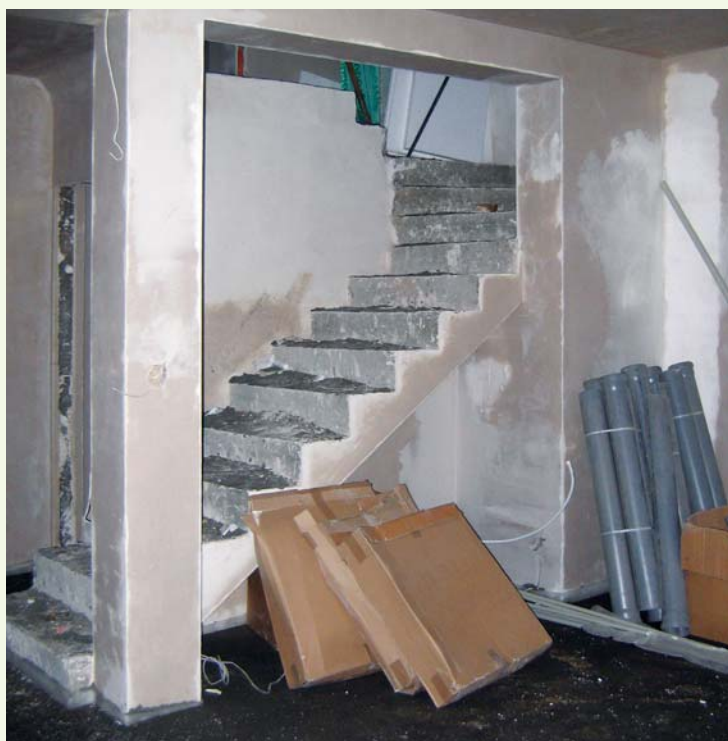
▲ Schody żelbetowe usytuowane w salonie
