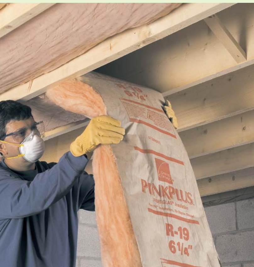
▲ Drewniane stropy gęstoźebrowe zawsze muszą być izolowane akustycznie lub termicznie
