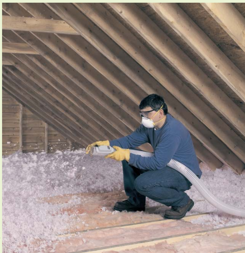
▲ Gęstoźebrowy strop nad ostatnią kondygnacją najłatwiej izoluje się wszelkiego rodzaju materiałami syrkimi lub granulowanymi
