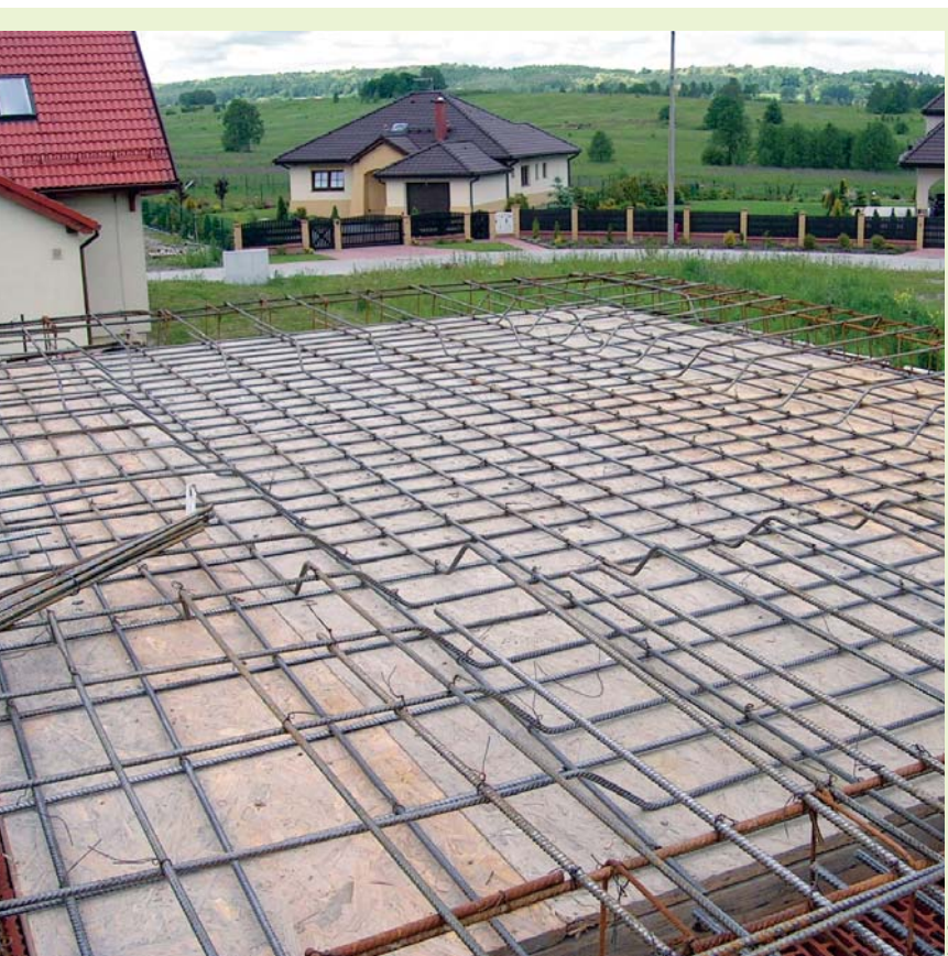
▲ Zbrojenie stropu żelbetowego
