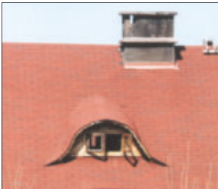
1 Ciemne plamy na kominie oznaczają konieczność jego remontu (fot. archiwum BD)
