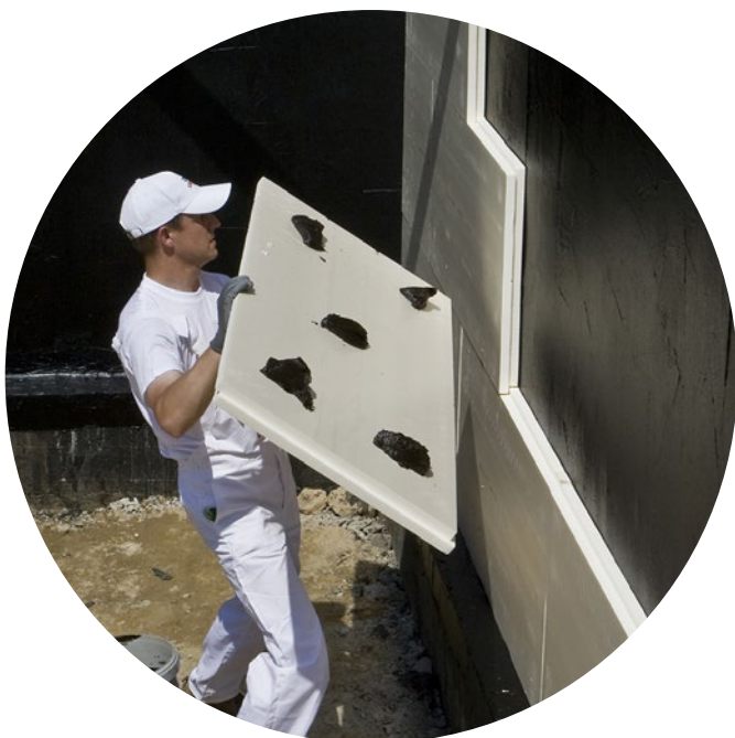
Zdjęcie 2 – Przyklejanie płyt URSA XPS metodą na placki
