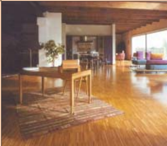
21 Interesujące zastosowanie „przemysłowej” posadzki z drewnianych lamelek (fot. Tavar)
