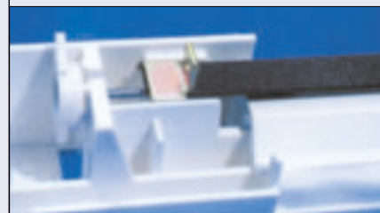
5 Czujnik w nawiewniku reguluje ilość dopływającego powietrza (fot. Aereco)
