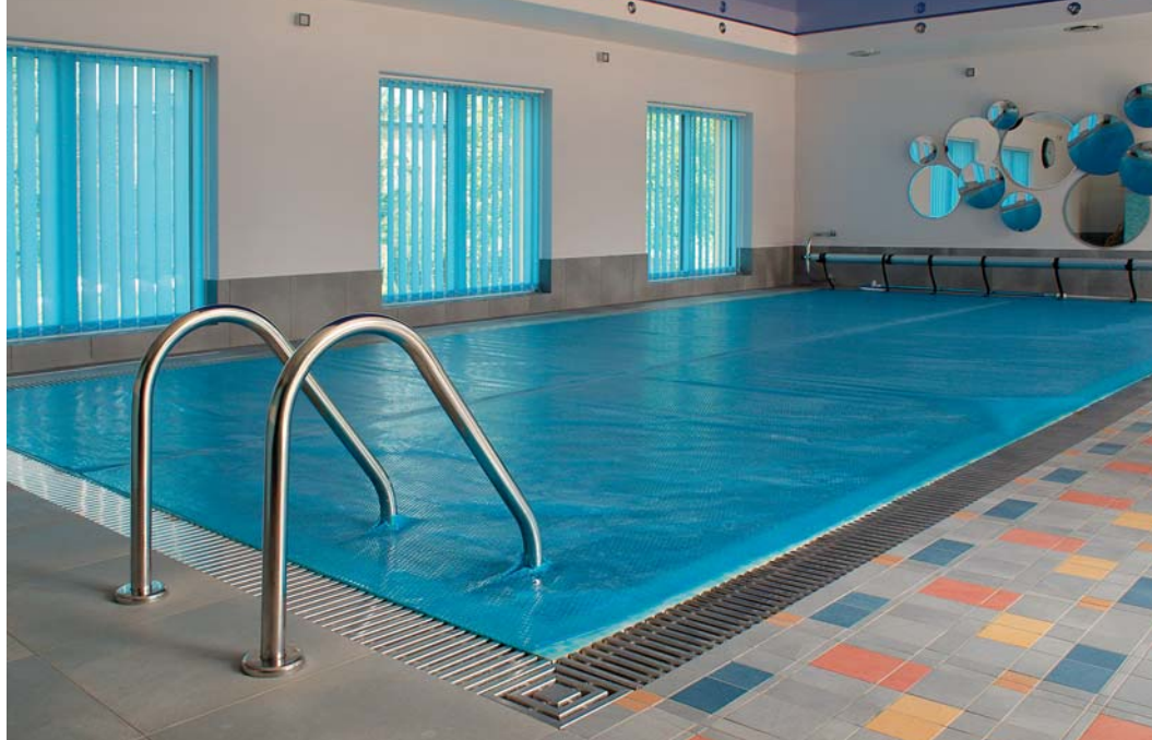
▲ Powietrze w pomieszczeniu basenowym jest ogrzewane dzięki współpracy pompy ciepła i wentylacji
