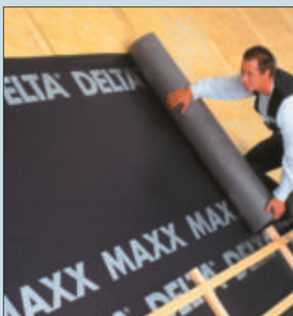
2 Szczególnie mocna membrana dachowa, bardzo odporna na wodę o wysokiej paroprzepuszczalności (fot. Dörken Delta Folie)
