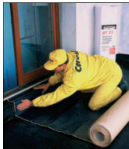
11 Samoprzylepna folia polietylenowa z masą klejąco-uszczelniającą zastosowana do hydroizolacji tarasu (fot. Henkel)
