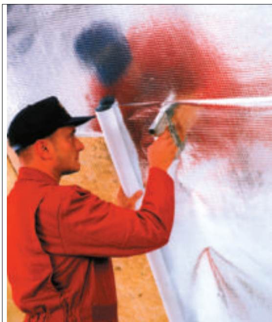
9 Paroizolacyjna (i wiatroizolacyjna) folia warstwowa odbijająca promieniowanie ciepłe do wnętrza pomieszczeń (fot. Dörken Delta Folie)
