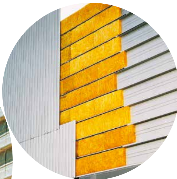
Zdjęcie 4 - Montaż płyt izolacyjnych URSA przy izolacji hal stalowych
