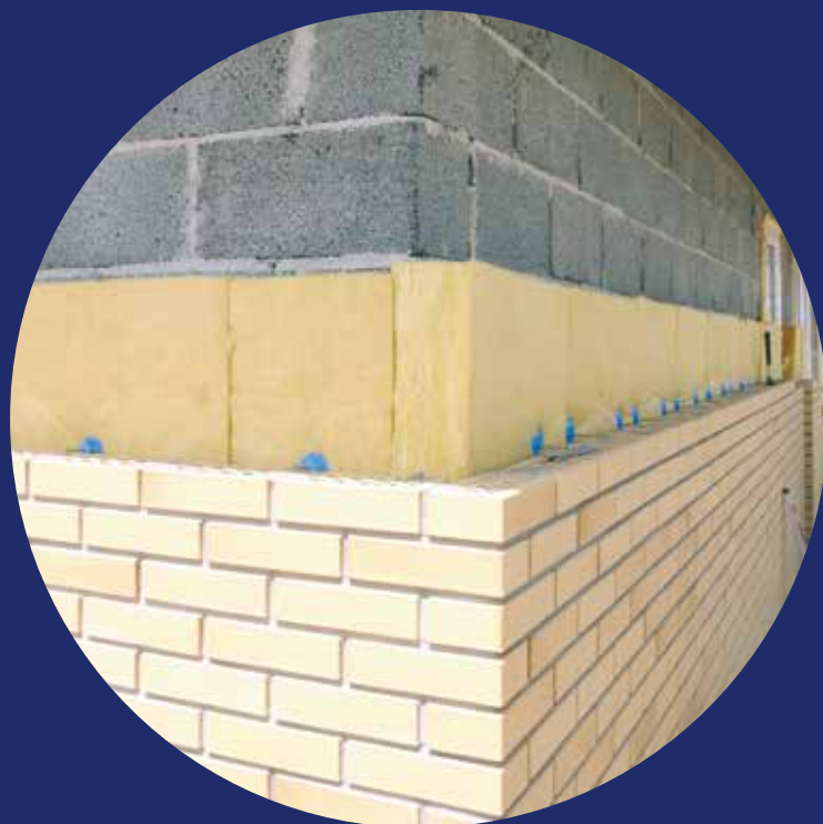
Zdjęcie 3 – Mur trójwarstwowy ze szczeliną wentylacyjną
